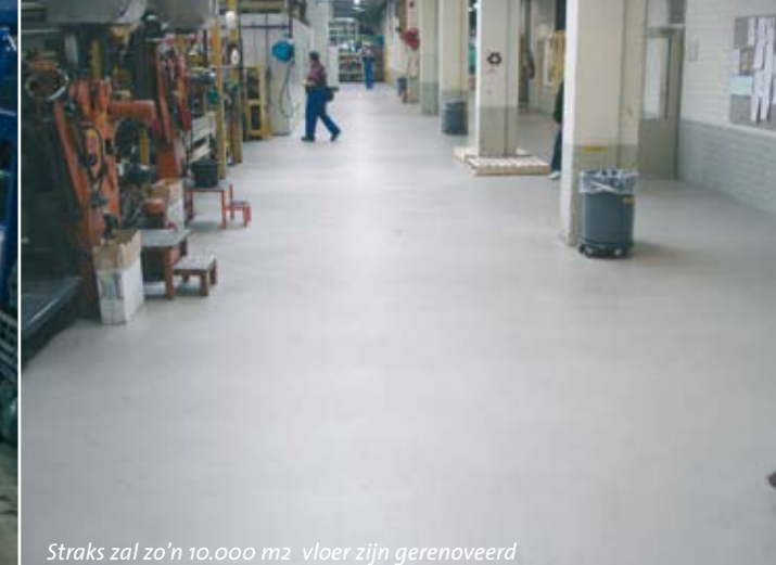
Straks zal zo'n 10.000 m2 vloer zijn gerenoveerd
